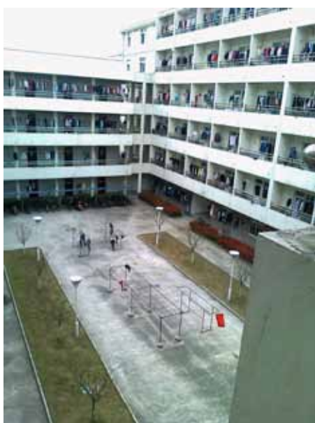
Dormitorio 9 en la fábrica Mingshuo, vista exterior
